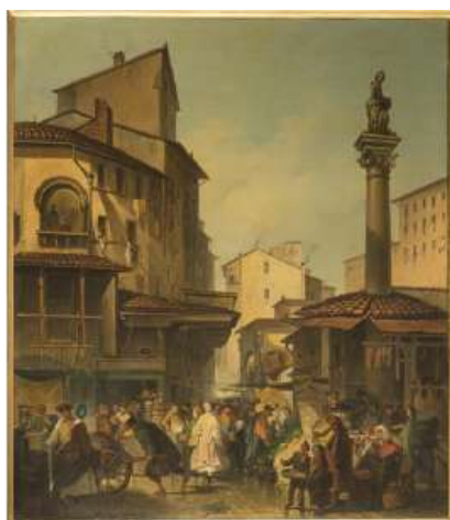
I.2 | Giuseppe Moricci, Veduta del Mercato Vecchio di Firenze , olio su tela, 1860. Firenze, Palazzo Pitti; a destra, sulla colonna, la statua ripristinata da Foggini.
