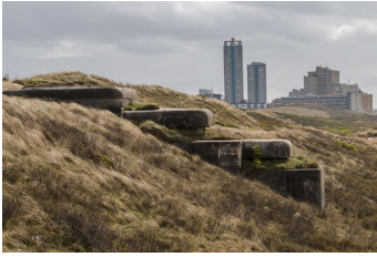
3 | Un Tiefbunker dell' Atlantikwall .
