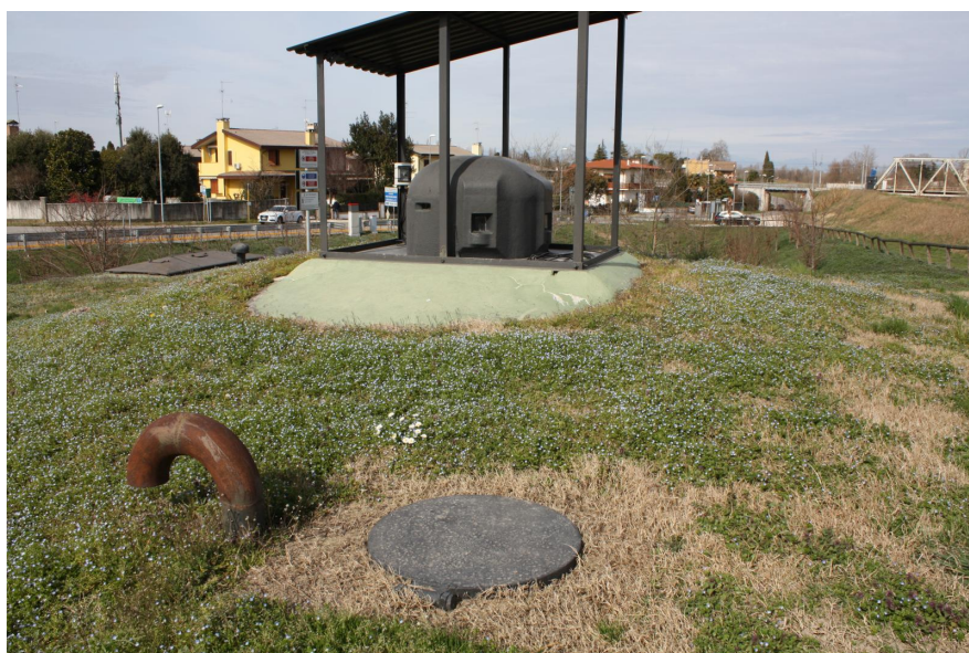
6 | Bunker di San Michele al Tagliamento (Venezia), recuperato a fini turistico-museali. Particolare della torretta PCO in acciaio e dei sistemi di ventilazione e di accesso (© Petriccione, 2019).
