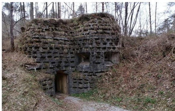
20 | Ingresso principale al bunker.
