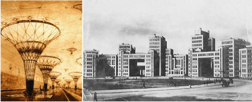
13 | Progetto di Taushkanov per la stazione Partizanskaja, con un sistema di pilastri metallici a forma di iperboloidi come le torri di Schuko.
