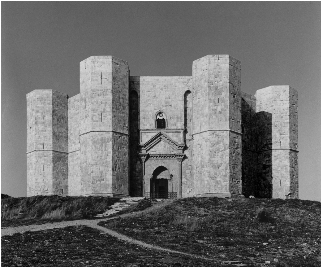
1 | Castel del Monte, von Ost. Foto Rafael Cardenas, 1997.
