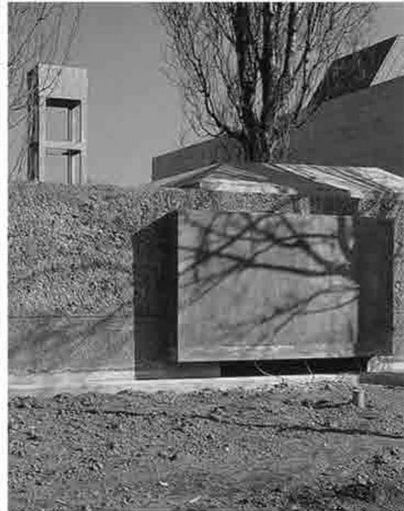
Francesco Venezia, Laboratorio prove materiali dello Iuav a Mestre, 1995-2002. Veduta dell'esterno del piccolo padiglione di testata in calcestruzzo liscio e calcestruzzo a strati e lavato.
