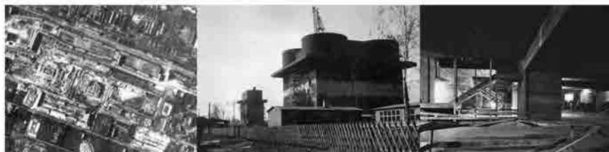
Il Flakbunker di Wilhelmsburg in costruzione, 1943.
