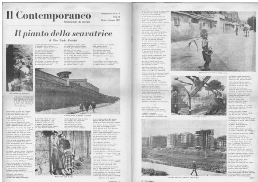
13 | Il pianto della scavatrice sul “Contemporaneo”, 8 giugno 1957
