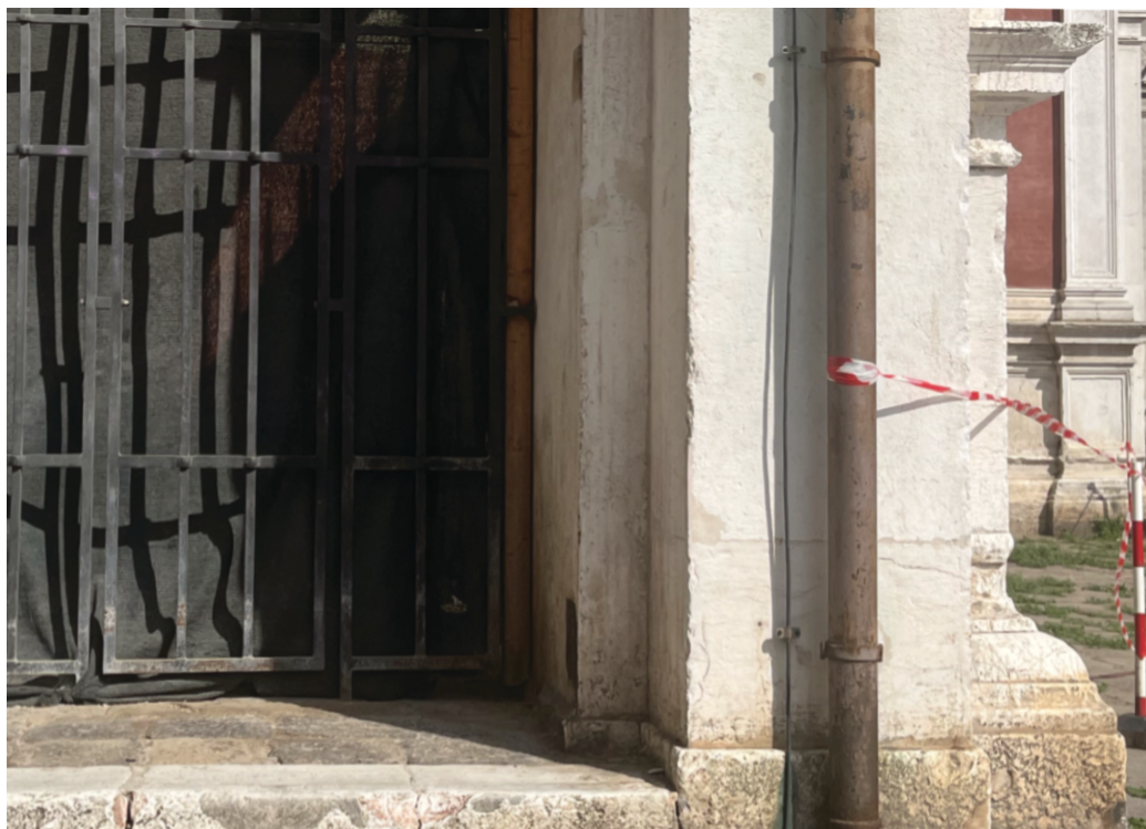
Lo stesso scorcio, oggi, 2026.
