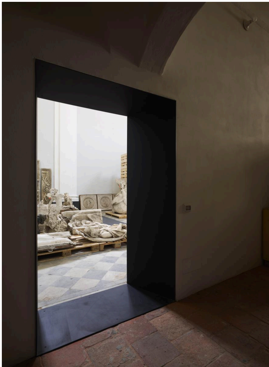
6 | Il vano porta di collegamento con i vani annessi è fasciato con lastre di acciaio verniciato nero a definirne la geometria tronco piramidale (fotografia di Pietro Savorelli).
