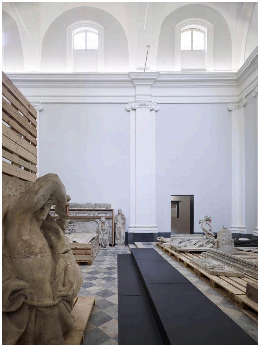
4 | Illuminazione artificiale realizzata con apparecchi a sorgente led posti sul cornicione: ogni elemento tecnologico è nascosto alla vista. Le lastre di acciaio verniciato vanno a formare i gradini mancanti del presbiterio (fotografia di Pietro Savorelli).
