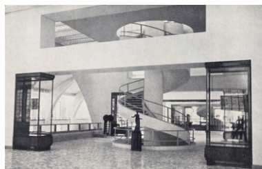
9 | immagine d'epoca in cui si vedono le travi di raccordo tra le arcate una delle scale a chiocciola
