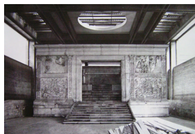
4 | L' Ara Pacis ricostruita all'interno della 'teca' ancora in costruzione.
