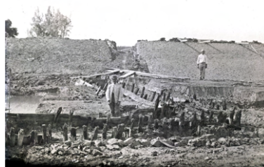
12 | La doppia palizzata del recinto S (A-B in pianta) quasi completamente scavato. MAN Aquileia, Archivio fotografico, neg. 1492.
