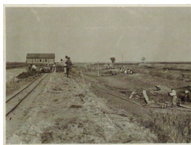
8 | Il canale-hangar dell'isola Gorgo in corso di scavo, fine luglio - inizio agosto 1917. Panoramica, probabilmente da ovest (MCR, Album A2, nr. 1375)
