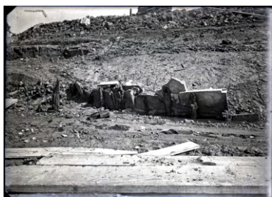
13 | Una porzione della doppia palizzata del recinto N (C in pianta). Sono visibili le tegole e gli embrici di reimpiego. MAN Aquileia, Archivio fotografico, neg. 1490.
