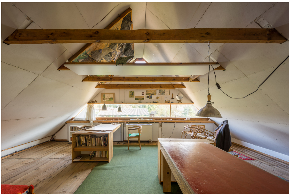
11 | Lo spazio-cannocchiale dell'area studio-notte al primo piano. La trasformazione della casa di vacanze a residenza ha reso necessaria la coibentazione della copertura, nascondendo così la struttura del tetto di cui restano a vista solo le travi passanti. Alcuni arredi provengono dall'appartamento in Via Sędziowska. Foto: Jakub Certowicz. Courtesy of the Museum of Modern Art in Warsaw.
