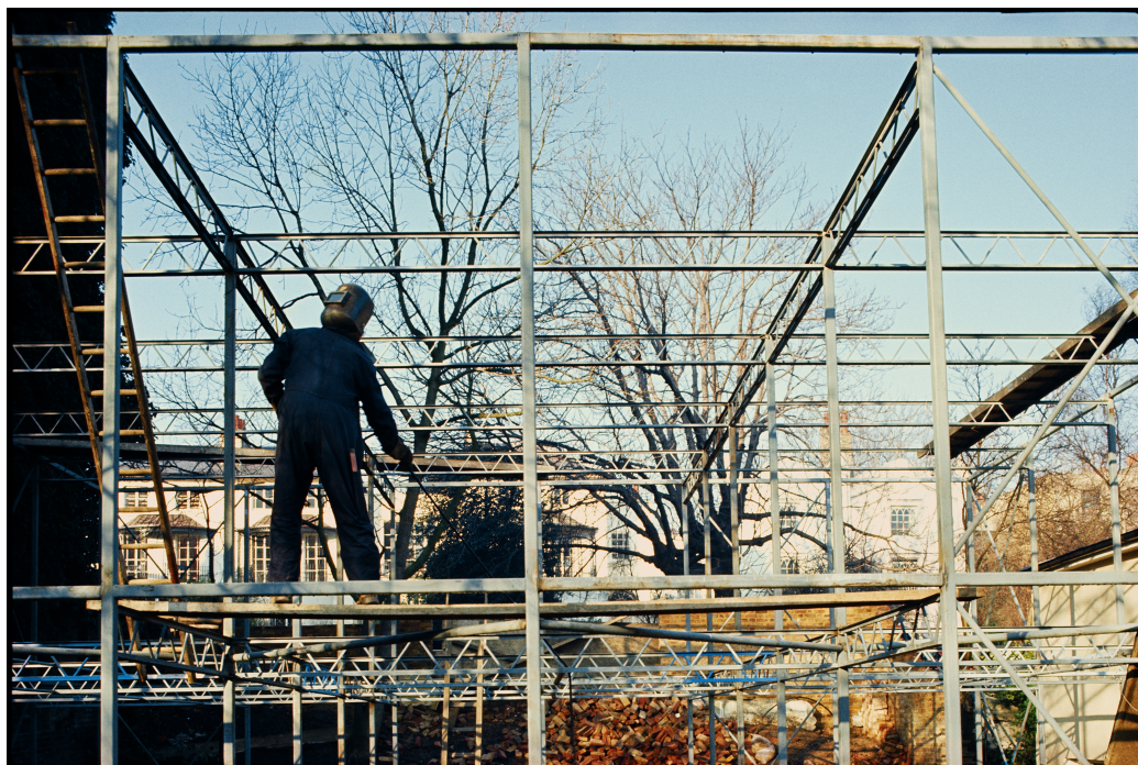
3 | Hopkins Architects, Hopkins House , Londra, 1975-1976. Fasi di montaggio della struttura in acciaio. ©Hopkins Architects.
