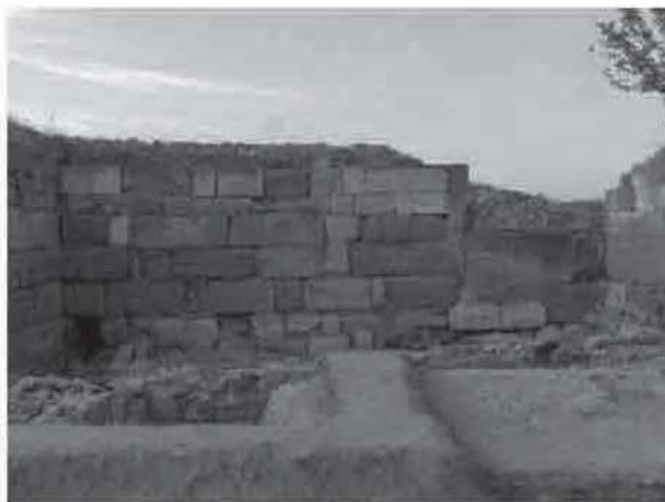
Il muro sud della Porta Maggiore, III secolo (a sinistra delle mura nell'immagine precedente); si notino i rocchi di colonne di recupero impiegati nella base del muro
