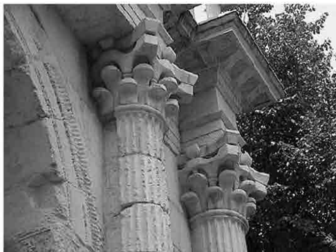
Arco dei Gavi, capitelli delle semicolonne (rico- struzione)
